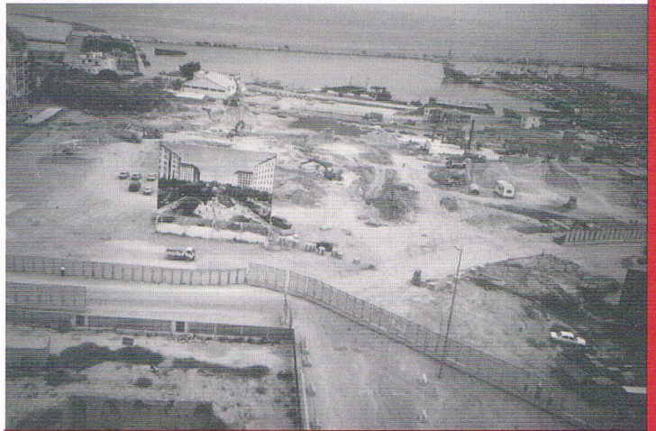
Perspective sur les chantiers du tell ancien et projet futur de Solidère dans cette zone
