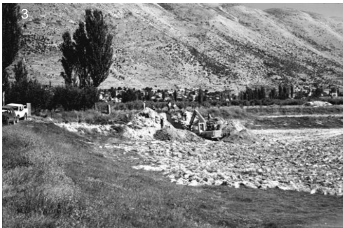
3 Creusement de la tranchée du déversoir.
