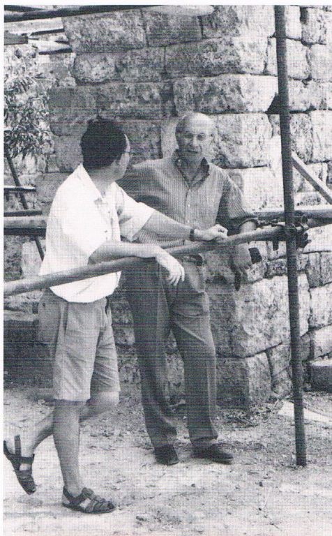
Mr. Camille Asmar supervisant les travaux
